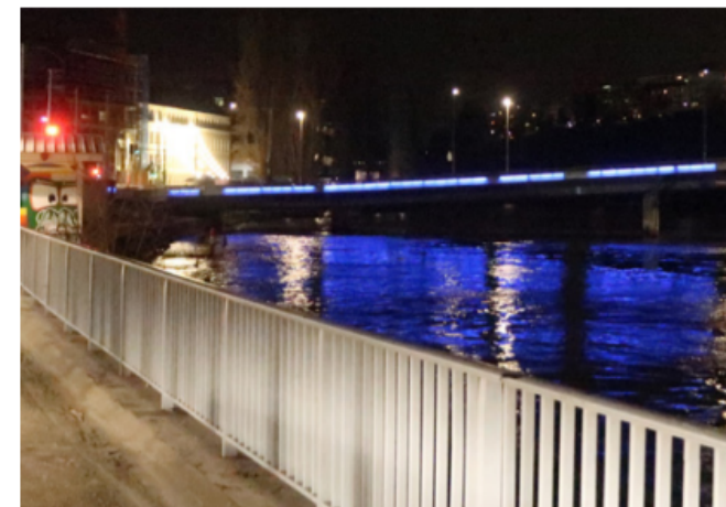
Illumination du pont de Sous-Terre : inapproprié
